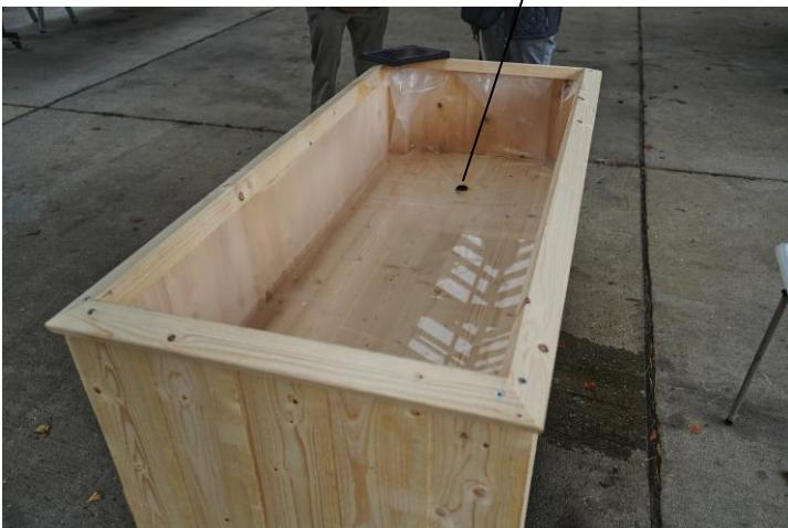
Jetzt kann der Beet-Bereich mit PE-Folie ausgekleidet werden, an den Ecken falten und an die Kanten der Verkleidung ansticken. Zuvor aber noch die Leitung für das Solarpaneel legen und die Halterung für Solar anbringen (siehe Seite 6). Mit der Leiste wird dann der Folienwulst überdeckt.
