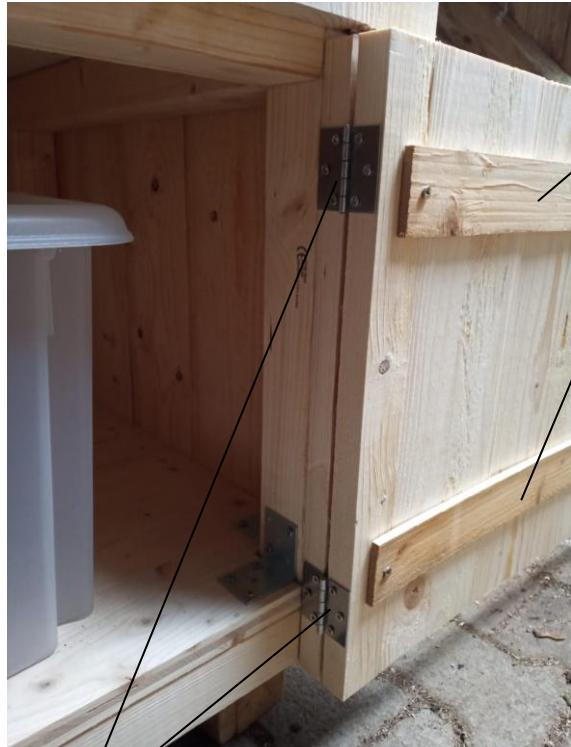
Nut- und Federhölzer verleimen und auf der Innenseite mit zusätzlichen Querleisten verschrauben (stärkere Leisten als hier gezeigt empfohlen: 2cm stark).
