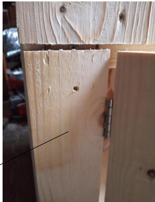
Mit Scharnieren werden sie an gesondert zugeschnittenen Leisten angeschraubt, diese schließen mit der Innenseite der Pfosten ab.
